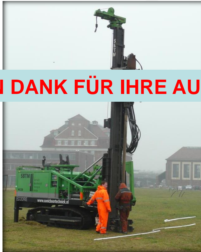
sonisches Bohrverfahren
