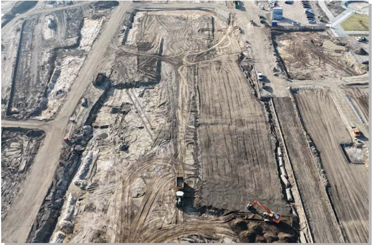
Übersichtsfoto Lok-Viertel Areal während der laufenden Kampfmittelsondier- und Bodenmanagementarbeiten (MuP, 2025)
