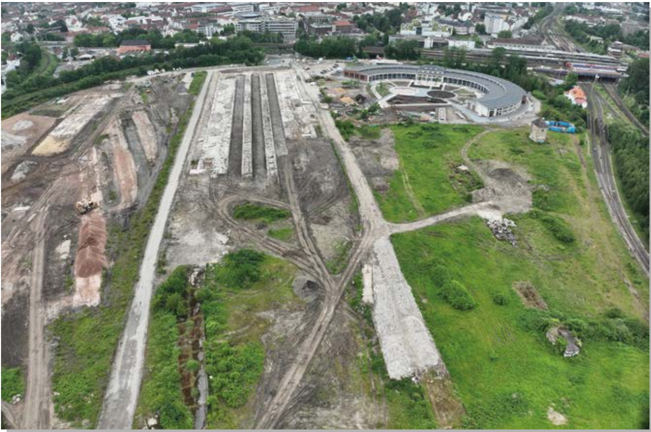
Übersichtsfoto Lok-Viertel Areal während der oberirdischen Rückbauarbeiten (MuP, 2024)
