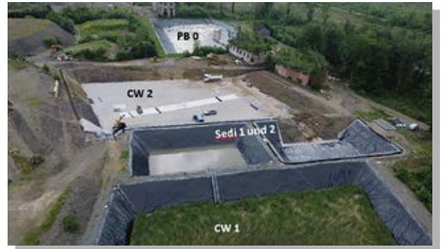
Bau des Constructed Wetland 2 (Bildmitte), bereits begrüntes Constructed Wetland 1 (untere Bildhälfte) (Quelle: IABG).
