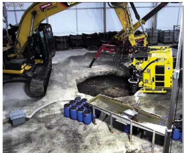
Abbildung 3: Schächte bei der Probeöffnung 2019
