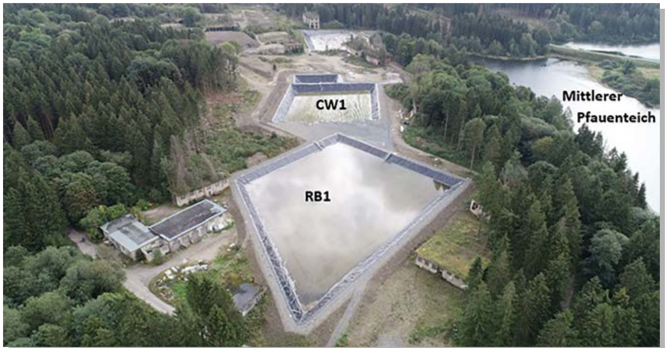
Drohnenfoto der Anlage Bauabschnitt I im September 2021: im Vordergrund Rückhaltebecken 1, Bildmitte Constructed Wetland 1, kleines Becken dahinter Sedimentationsbecken 1 (Quelle: Landkreis Goslar)
