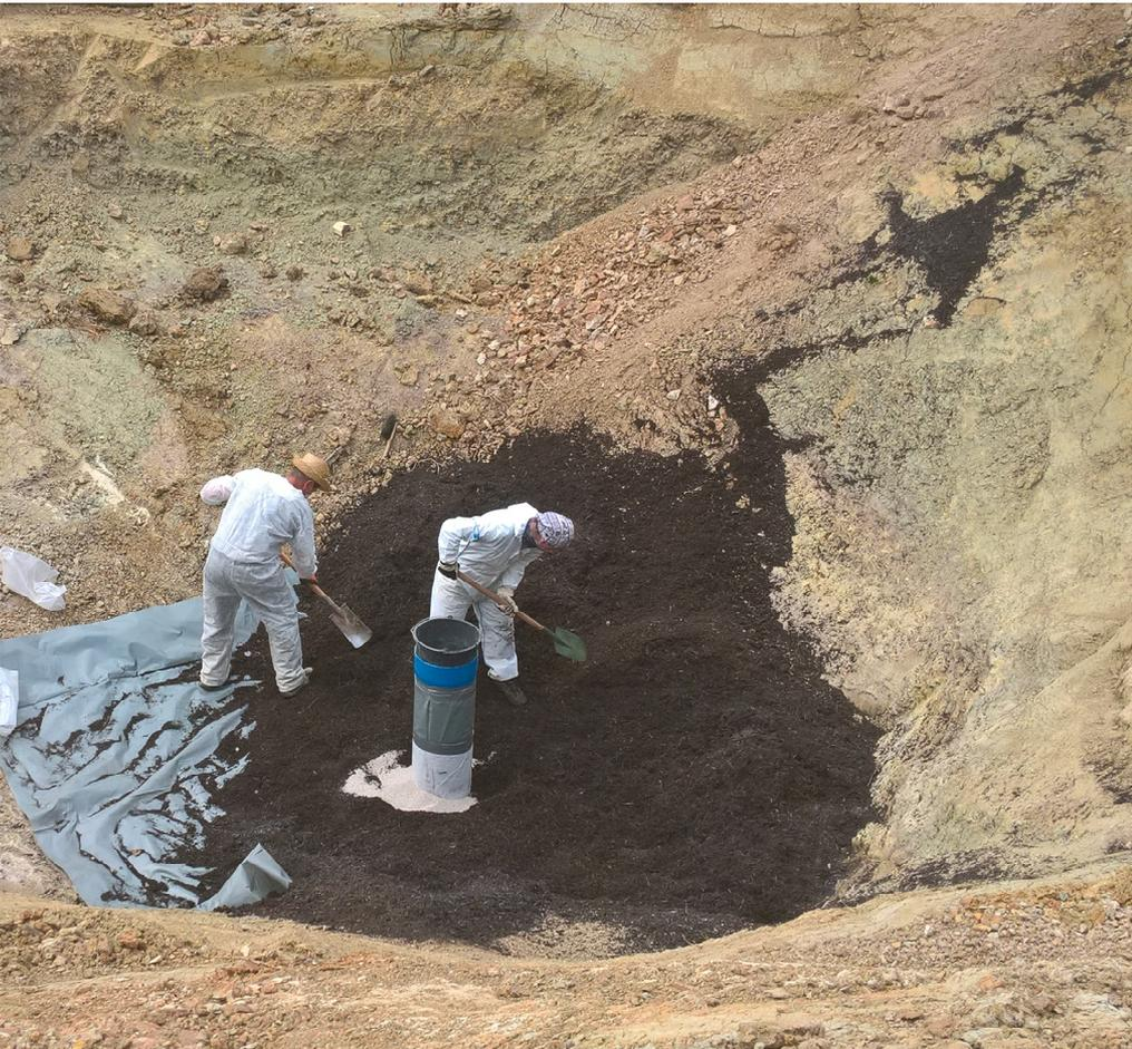
Ausbildung der Trichtersohle du Herrichtung des Beweissicherungsrohres
