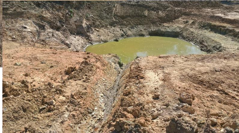
Kombination photolytischer und mikrobieller ETV- Abbau (offene Gräben) sowie Immobilisierung (Rigolen)
