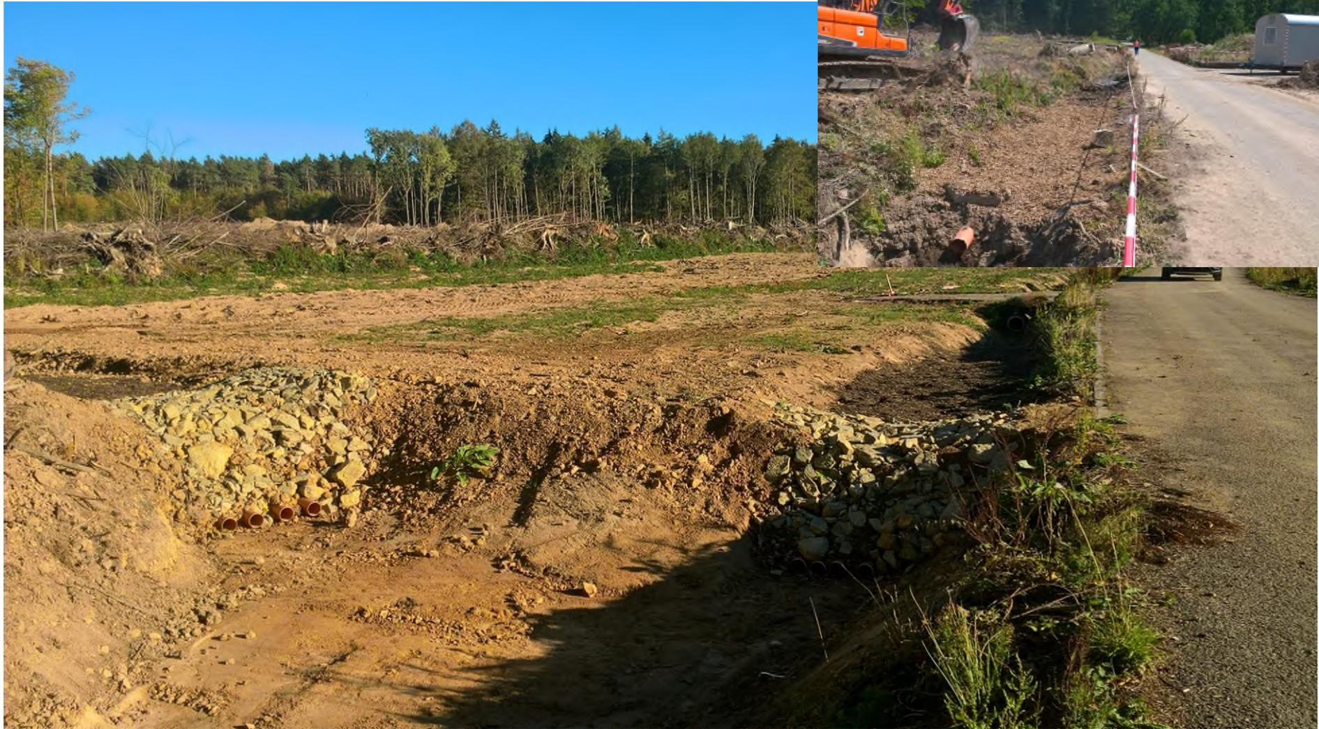
**Kompost- Riegolen, Verbesserung der Durchlässigkeit durch Drainagen, Hackschitzelabdeckung**
