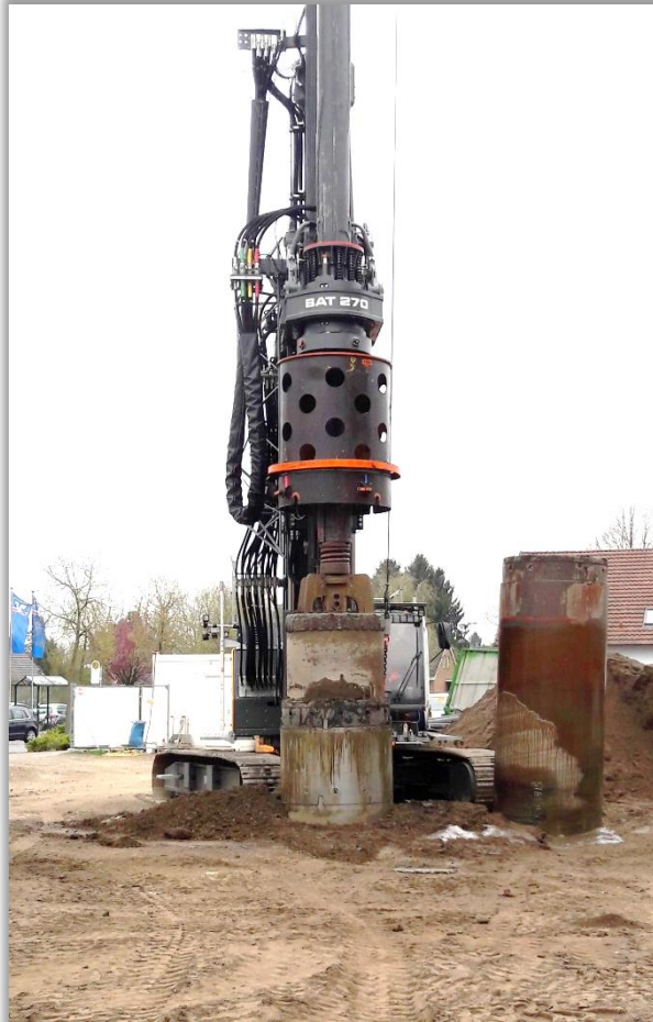
Einbringen eines Schutzrohres
