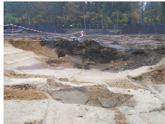
Sanierung Sprengplatz Naleppa (Quelle: IFAH GbR)
